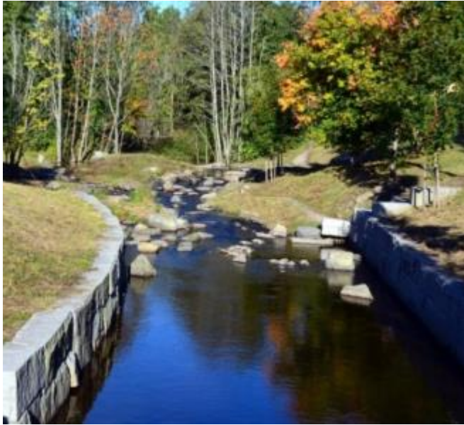
Figur 34. Öppning av bäck med både 'hårda' och 'mjuka' kanter. Foto: Oslo Kommun
