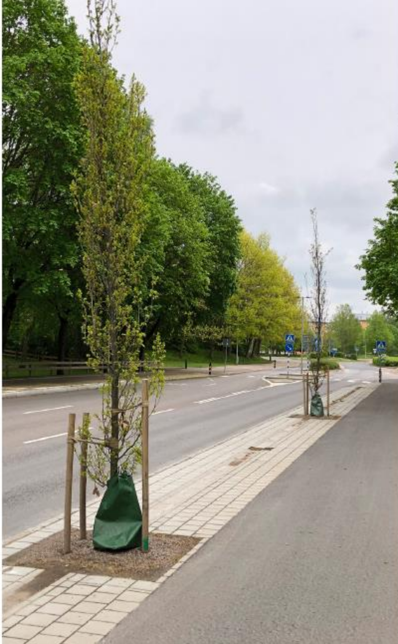
Figur 14. Träd på hårdgjord yta på stråk av öppet förstärkningslager (Edge, Levande gaturum – en handbok i Blågröngrå system, 2022)
