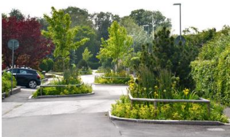
Figur 22. Gata med gröna lösningar för dagvatten (Edge, Rundedalsgatan i Vellinge).
